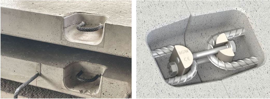
Image 2 : réservation dans la dalle et connecteur
