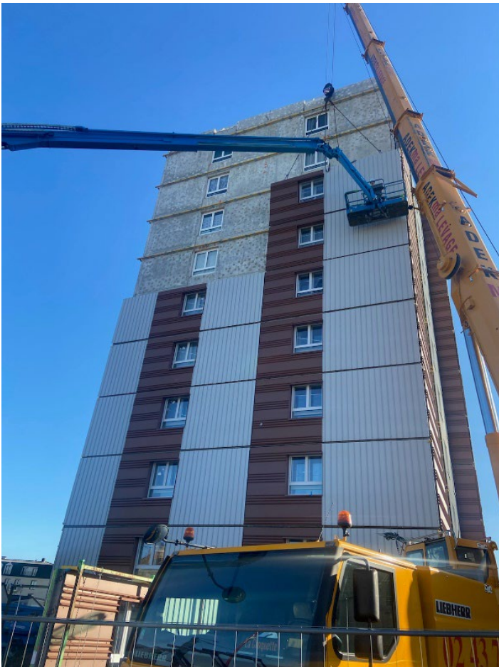
Les nacelles et grues posant les murs de FOB.
