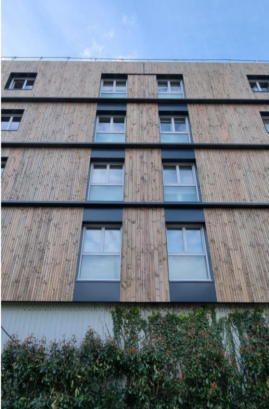
Chantier en cours, menuiseries extérieures intégrées à la FOB
