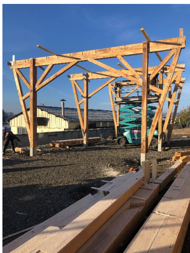
Mise en place des portiques du RDC
