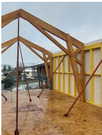
Mise en place des MOB
