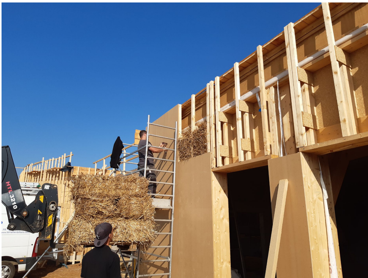
Mise en place de la paille dans les MOB et caissons paille (crédits photos : Pierre-Etienne ROBINET)
