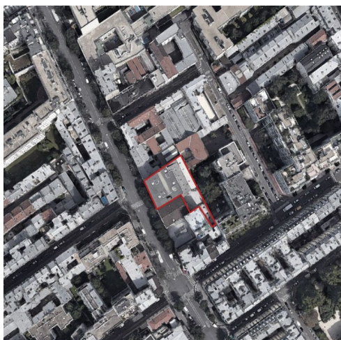
Vue aérienne du garage
