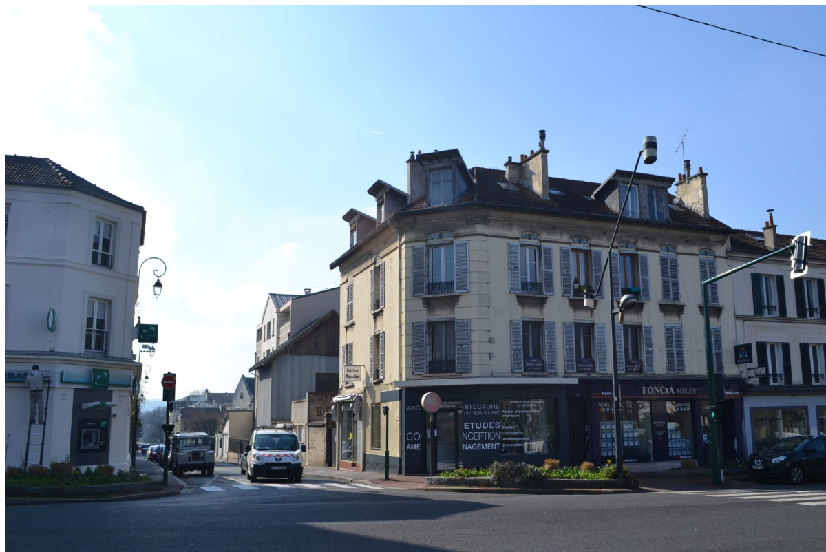
63 boulevard Carnot au Vésinet – bâtiment existant
