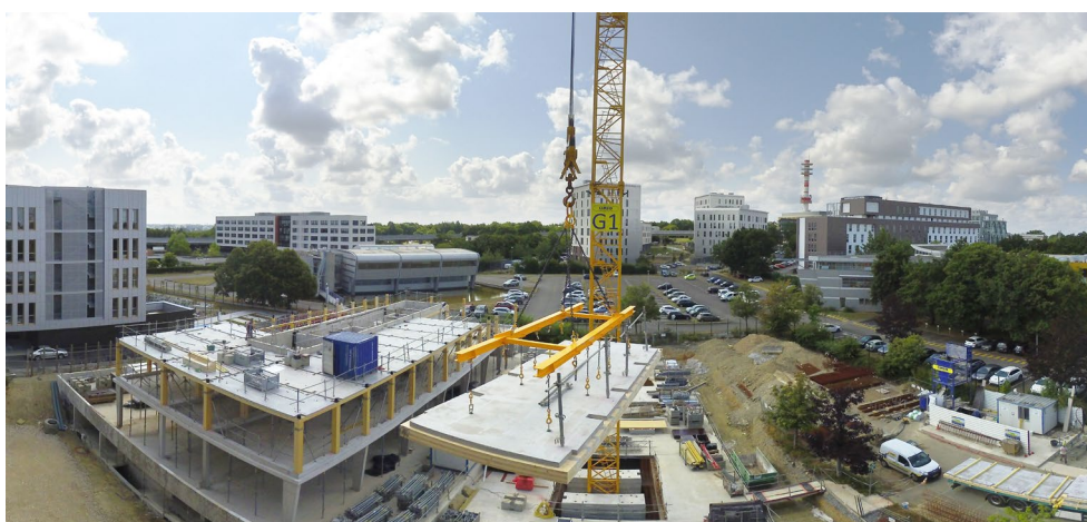
Image 8 : Pose des planchers HOB OA préfabriqués pour le bâtiment Canopia Business. Les planchers sont livrés en juste à temps sur le chantier et levés directement depuis le camion.
