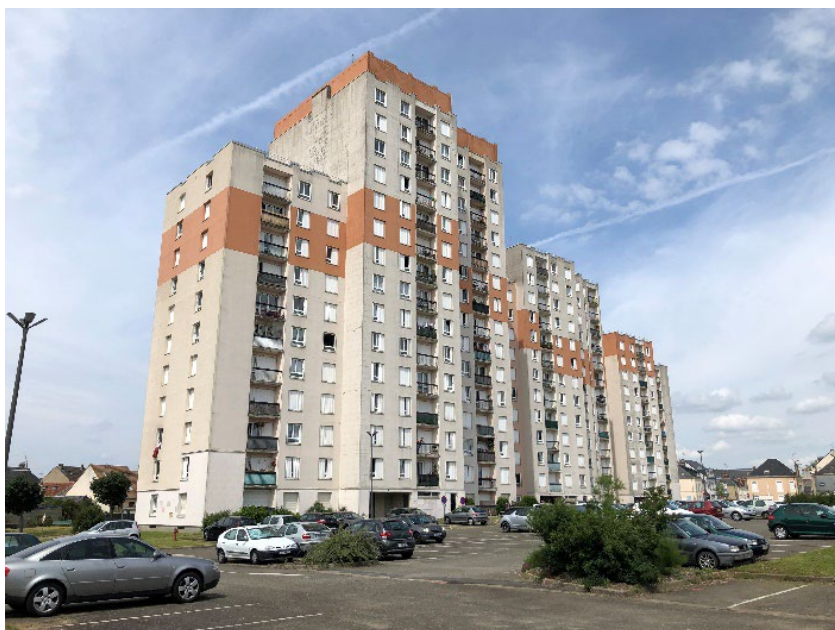
L'immeuble avant intervention
