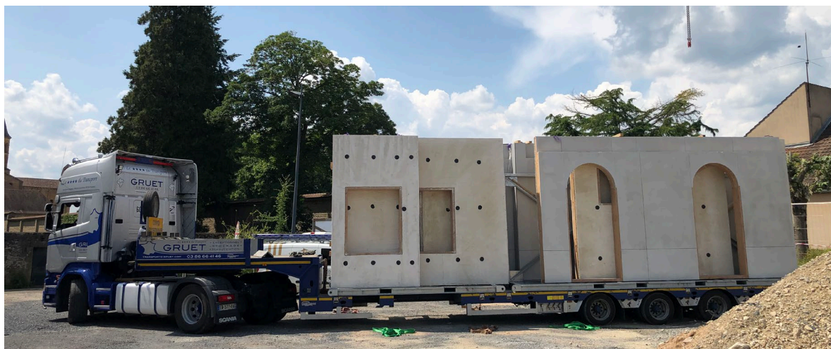
Image 12 : livraison des murs Wall'up sur chantier (crédit photo : Charpentiers du Haut Beaujolais)
