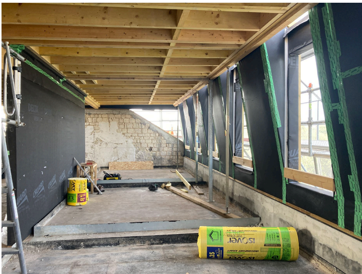
Travaux au R+3 : étanchéité provisoire, chainage, charpente mansardée, toiture
