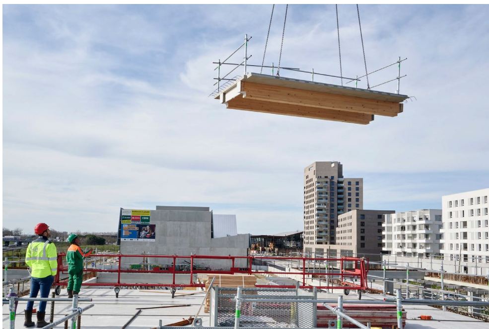
Image 3 : Levage de la dalle ATOM WOOD fabriquée hors site
