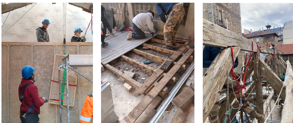
Image 12, 13 et 14 : Photo de démontage du bâtiment (A+1)
