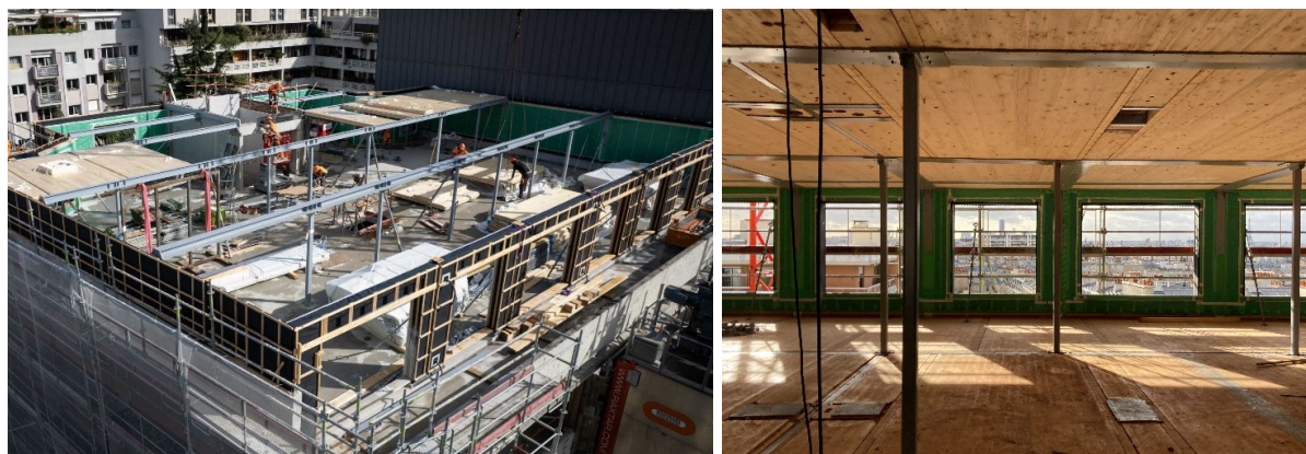
Photos de chantier de la surélévation bois
