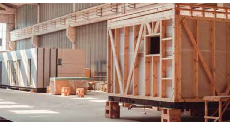
#Construction hors site - Modules 3D
