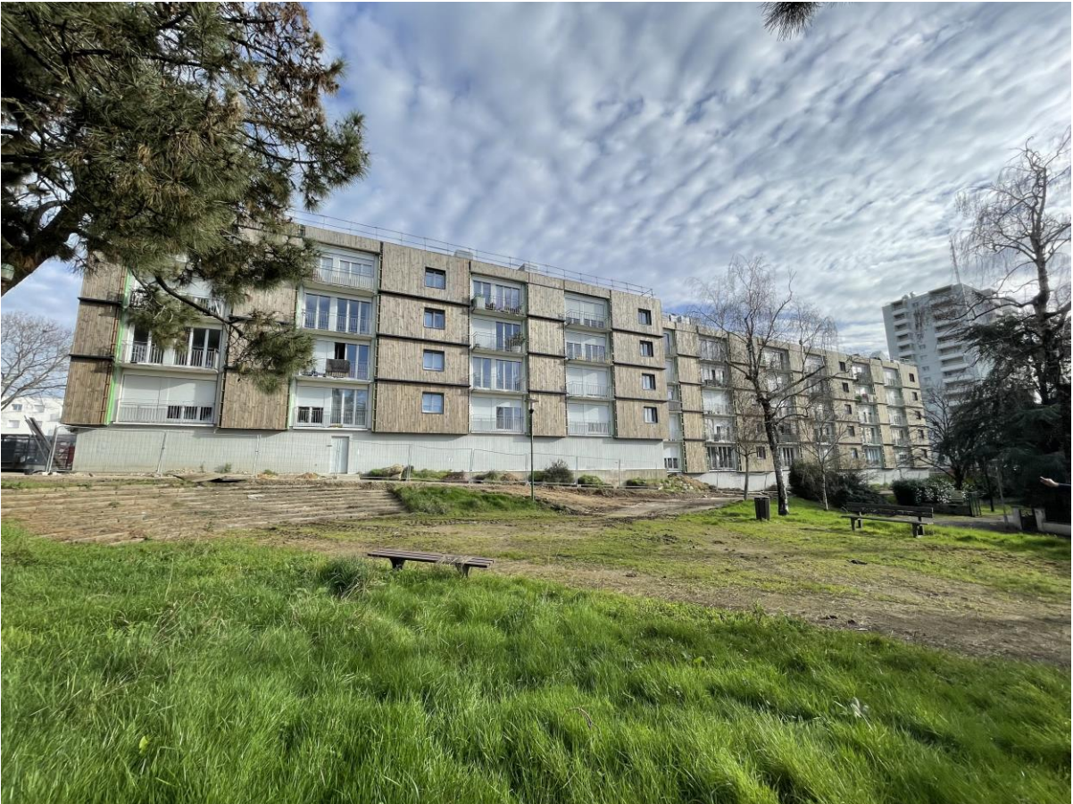
Pose des murs FOB en cours
