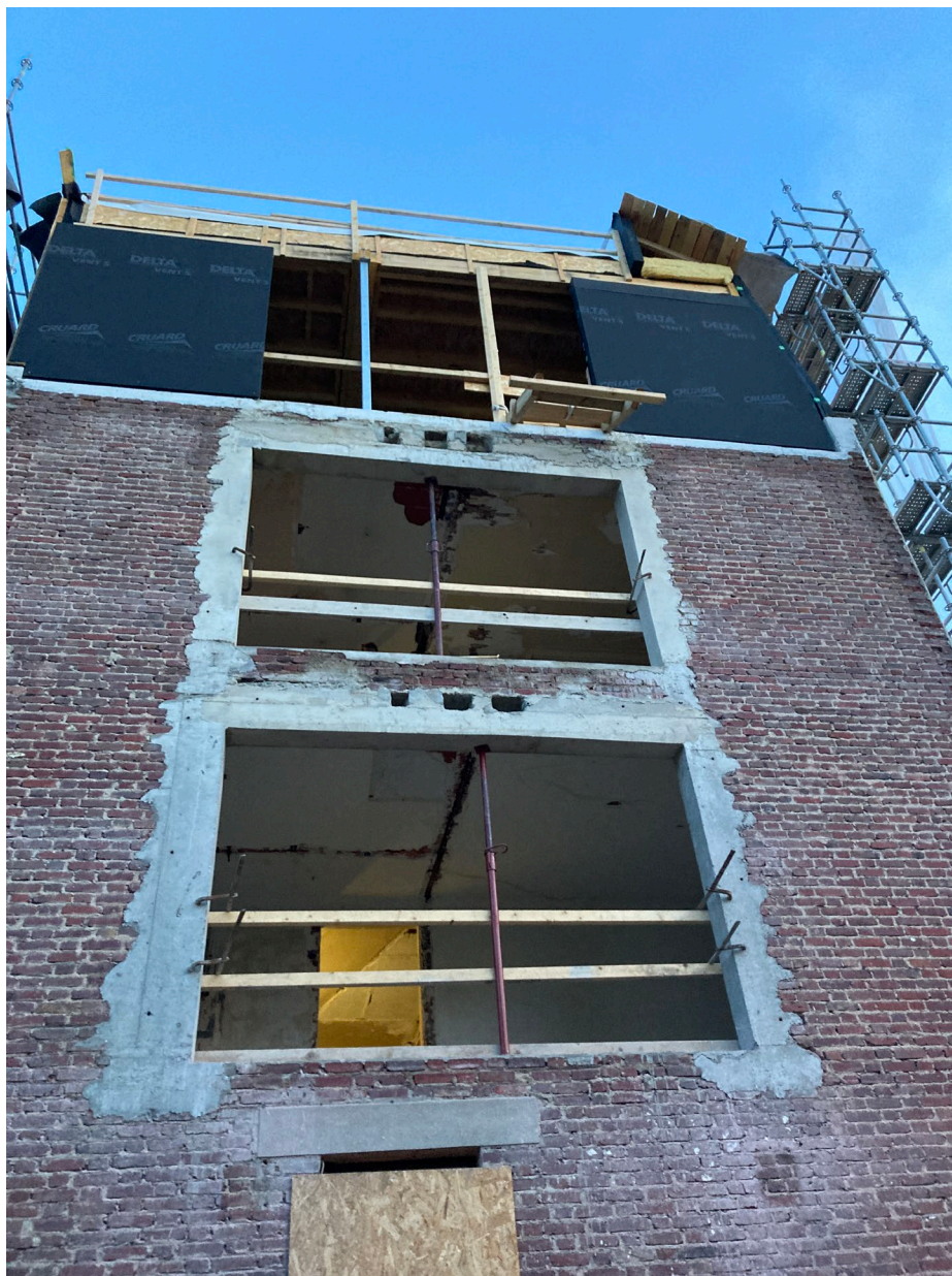
Ouverture des pignons sur l'extension
