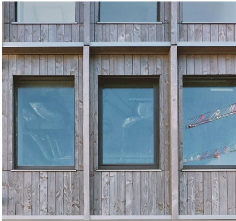
Bardage bois Douglas prégrisé en façade de Façade PE5
