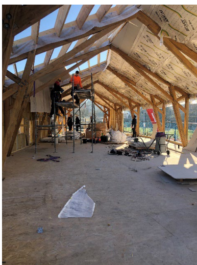
Mise en place des caissons de toitures
