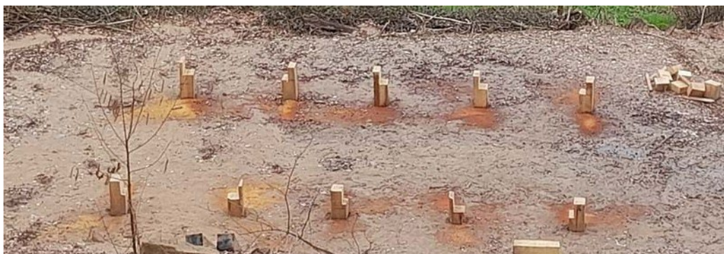
Image 7 : les pieux d'acacias plantés dans le sol servent de fondation – ©ONF
