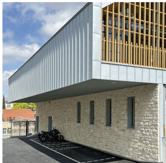
Récupération des pierres
