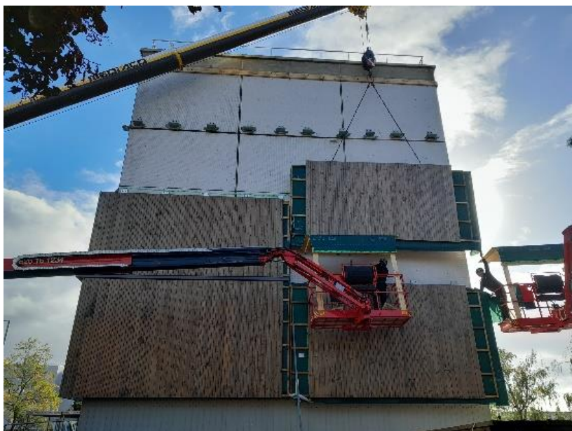
Pose des murs de FOB en cours avec nacelles et grue.
