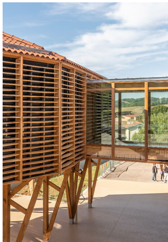
Image 3 : Vue depuis la passerelle extérieure © Sandrine Rivière
