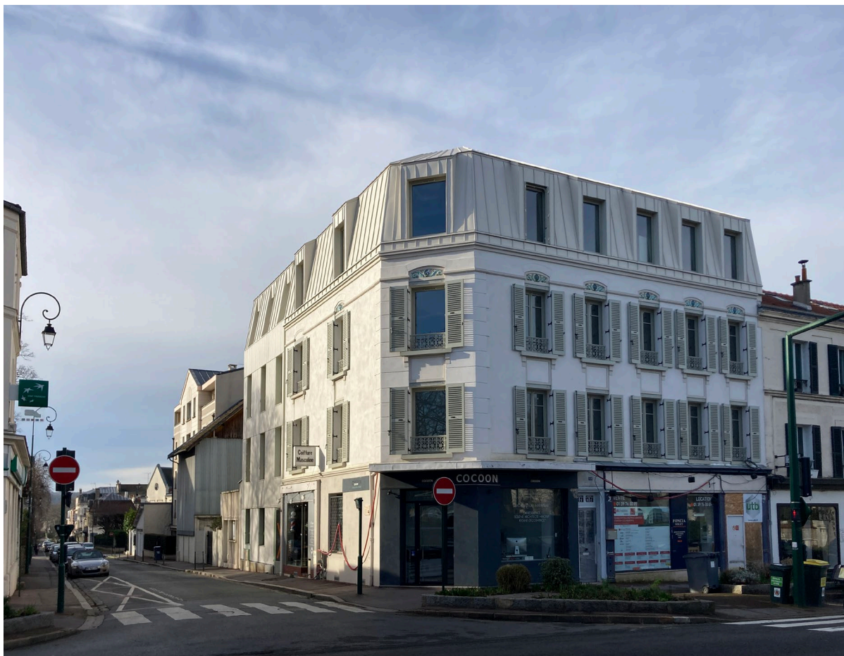
63 bd Carnot – Bâtiment réhabilité.
