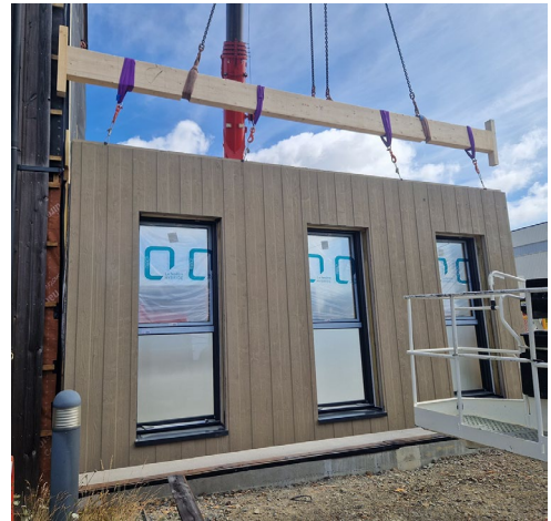
Figure 9 : Photo d'un mur au levage
