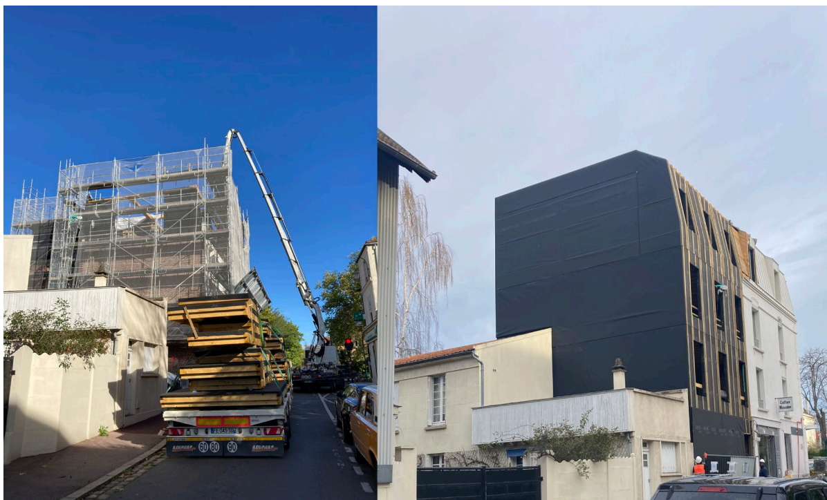
Extension bois sur pignon
