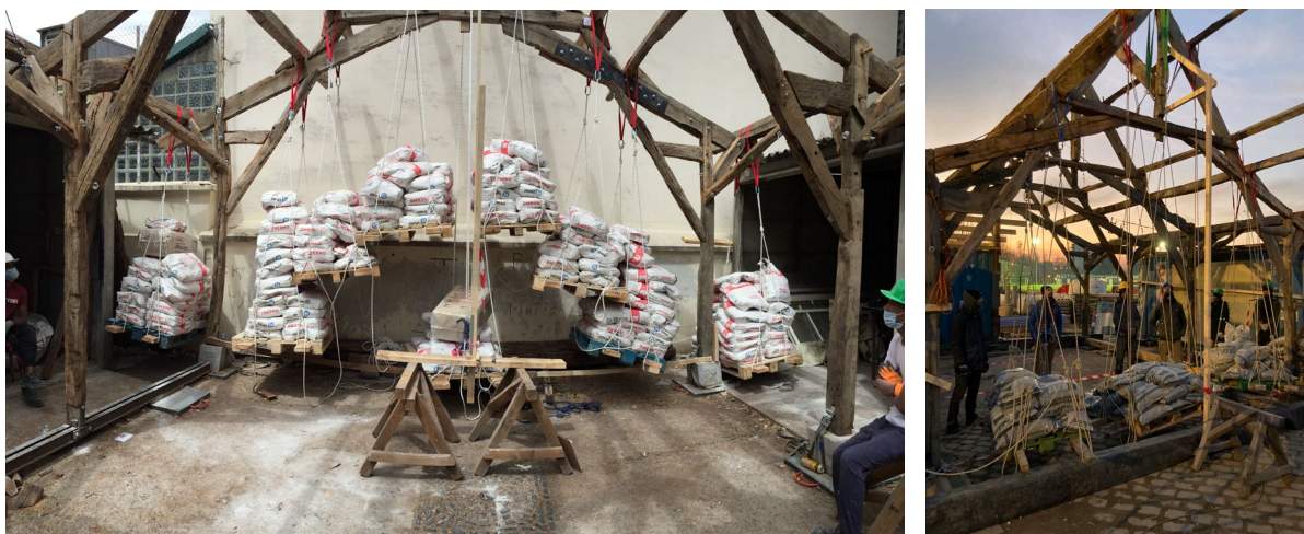
Image 7 et 8 : Photos des tests des mises en charge pour chaque montage de la charpente
