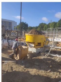
2 Mélange Formulation du béton damé: Granulats recyclés de la ZAC + Ciment blanc + Pigment + faible quantité d'eau
