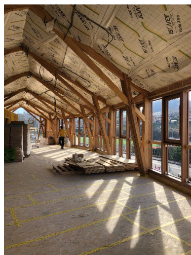
Mise en place des murs rideaux
