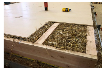
Image 11 : caisson de toit : ossature bois / isolation paille. (Crédit photo : Charp. Du Haut Beaujolais)
