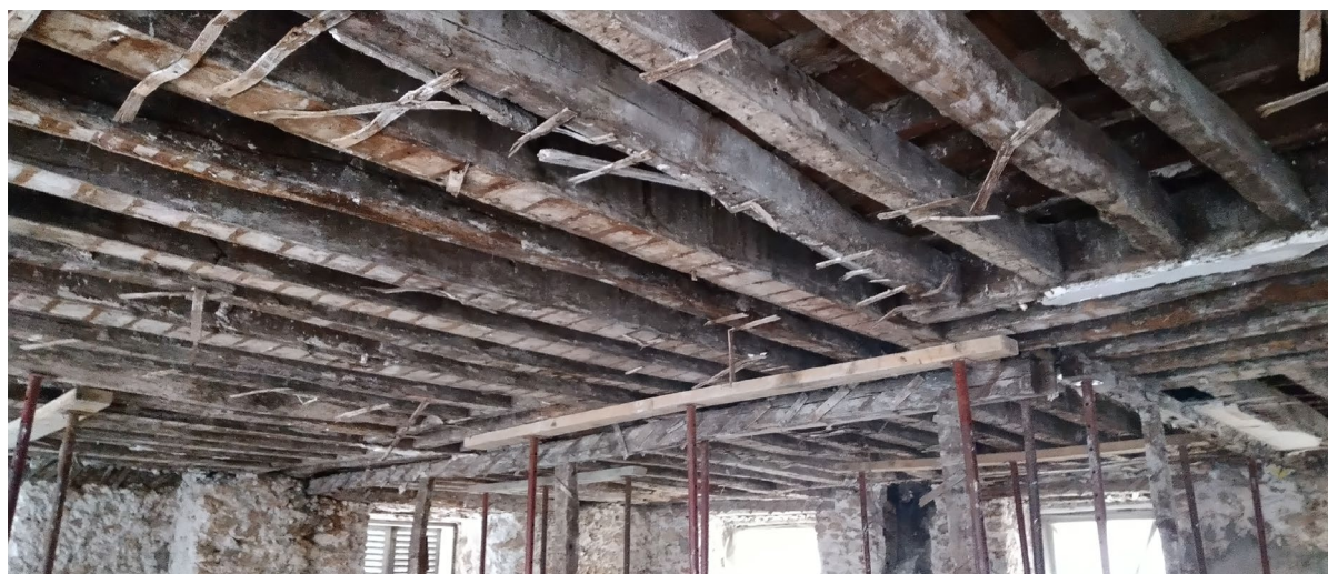
Image 1 : Photo Brunoy démontage du plancher existant
