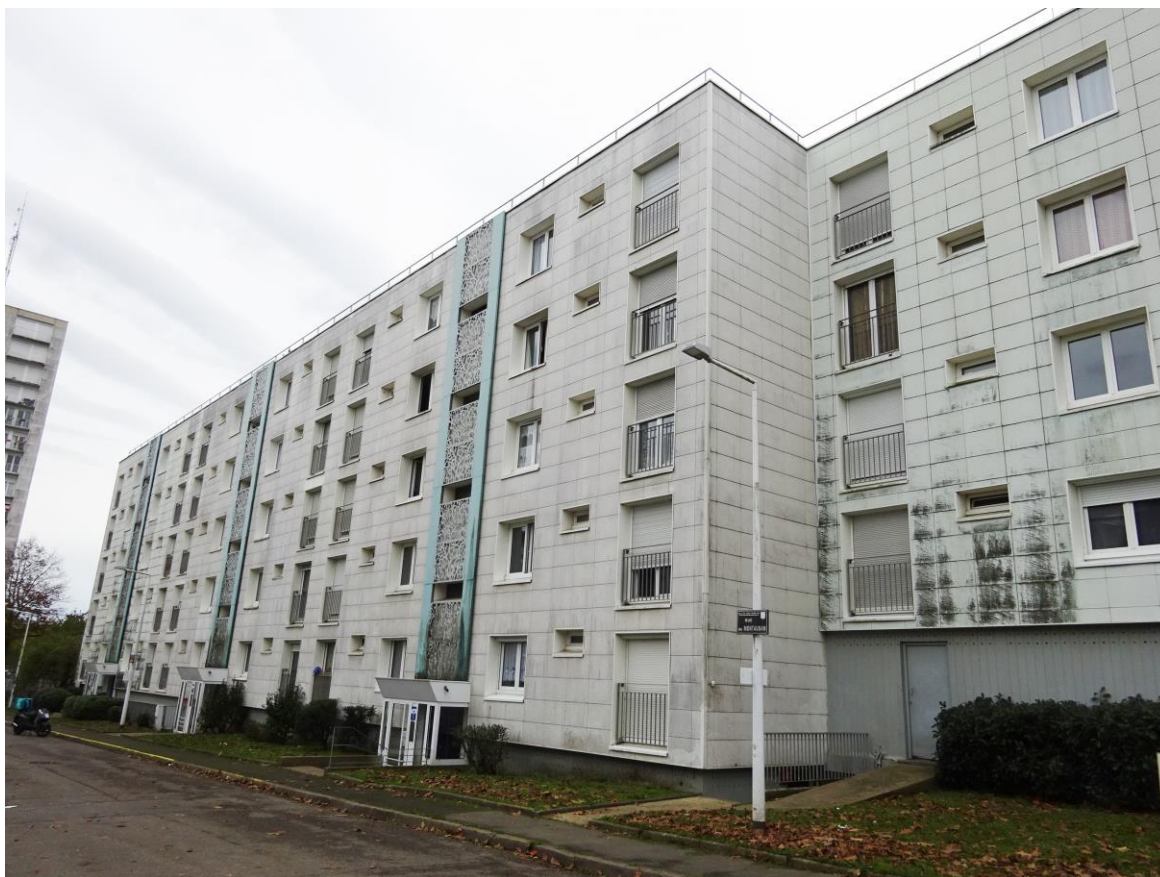
Le bâtiment existant
