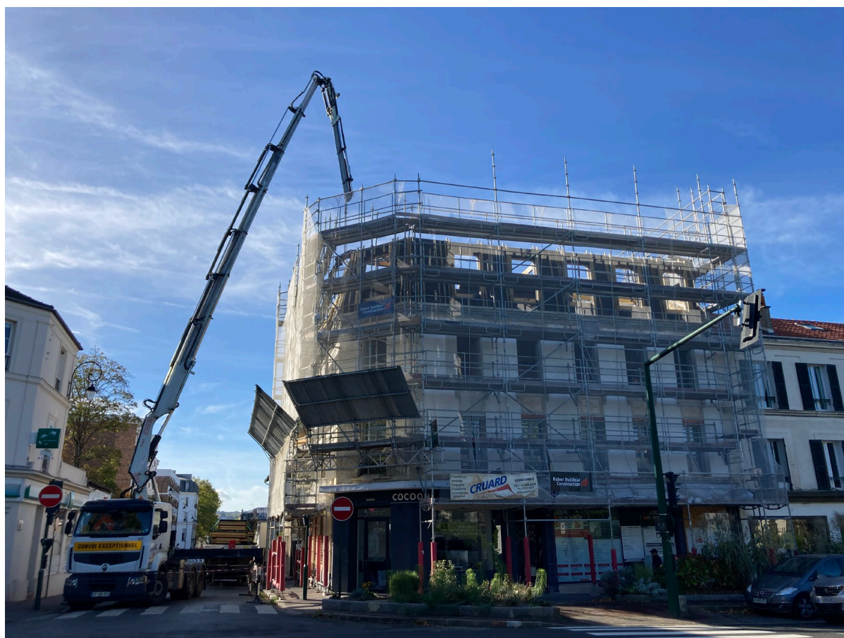
63 boulevard Carnot au Vésinet – travaux de surélévation – Cruard
