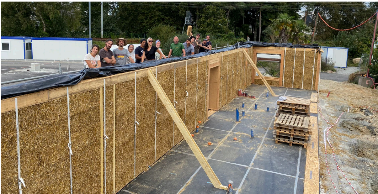
Chantier formation NEBRASKA Etudes et constructions paille
