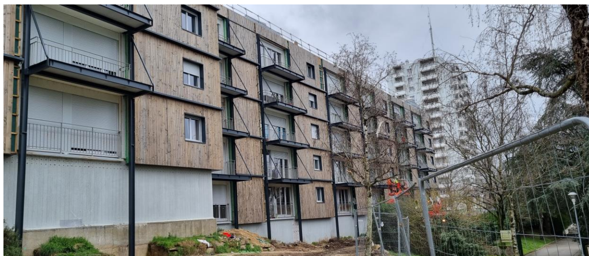
L'agrandissement des balcons en cours
