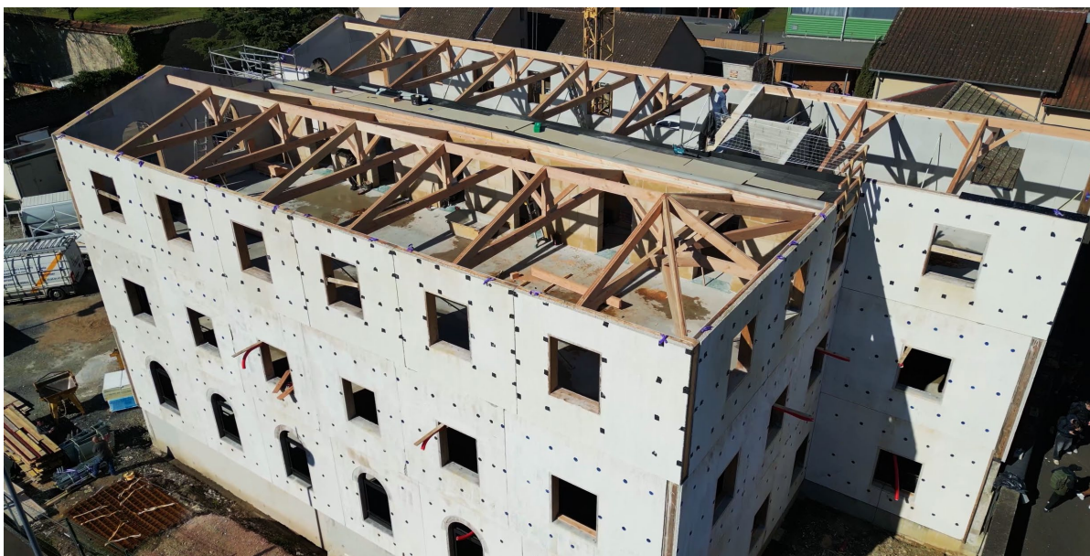
Image 8 : photo des 3 niveaux de MOB Wall'up béton de chanvre et charpente en douglas massif local. (Crédit photo : Charpentiers du Haut Beaujolais)
