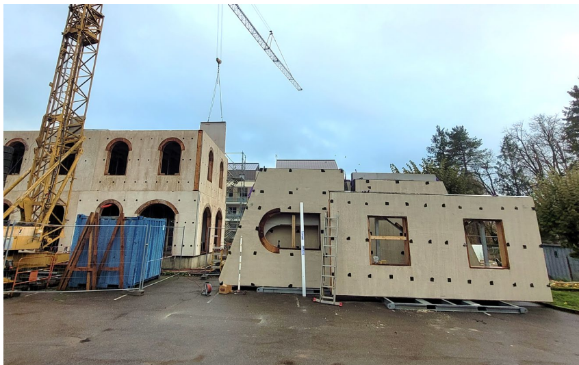
Image 7 : sur chantier, murs RDC et R+1 : mis en place et murs R+2 livrés, pas encore levés
