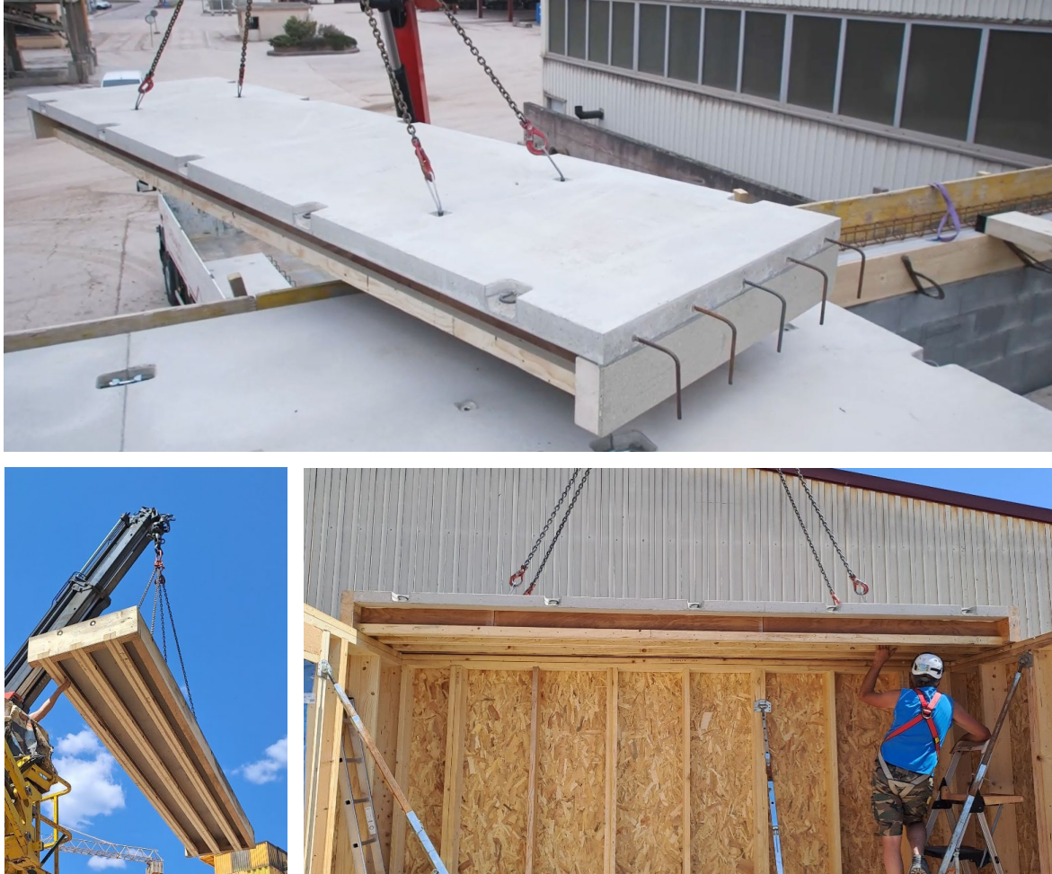
Image 8 : Photos de la construction du bâtiment démonstrateur
