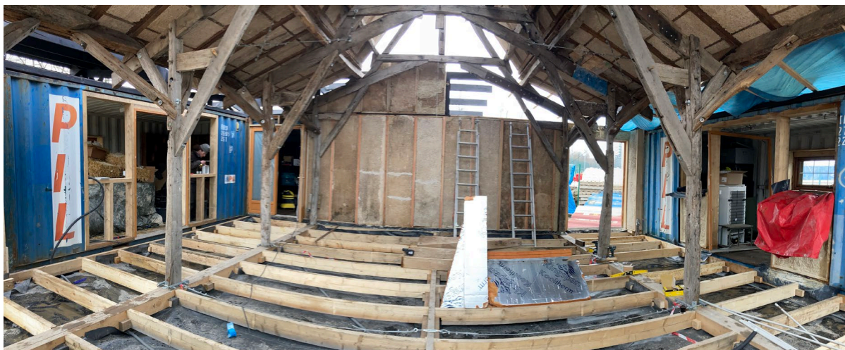
Image 16 : Photo de la Bricole en cours de remontage a la Gare des Mines
