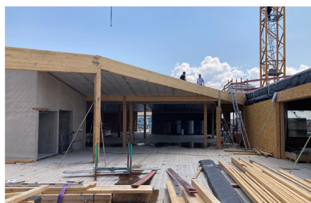
Image 5 : Photos du montage en cours de la structure et charpente bois
