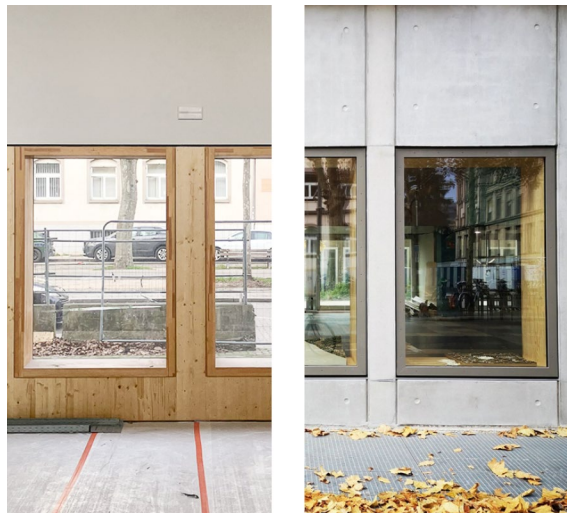
En chantier : baies percées dans le socle © COSA – RHB
