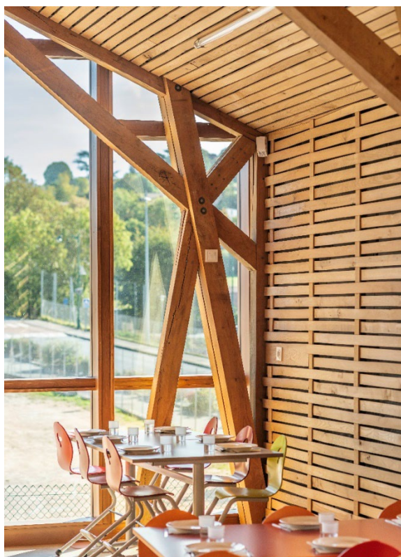
Image 5 : Habillage intérieur en châtaignier tressé © Sandrine Rivière
