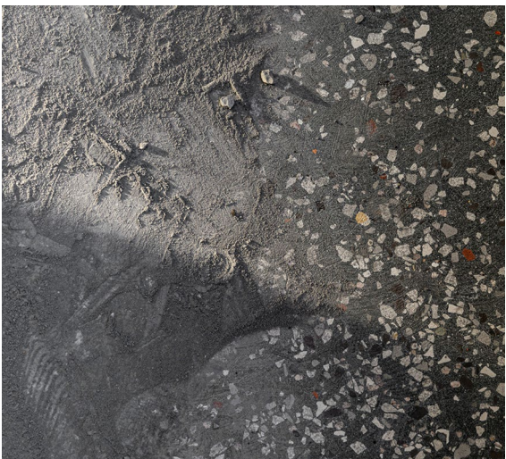
En chantier : terrazzo © Florry-Anne Simons, RHB
