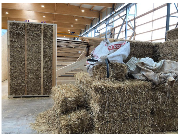
Image 6 : remplissage par bottes de paille en atelier, avant fermeture des caissons
