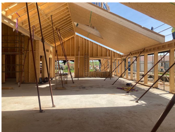
Image 8 : photographie de chantier de la salle multi-activités
