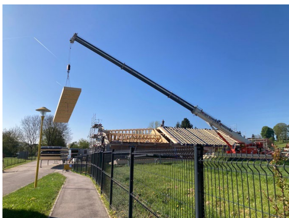
Image 7 : levage des caissons de toiture par camion-grue. Le levage de la structure bois et des caissons s'est déroulé d'avril à mai 2023.
