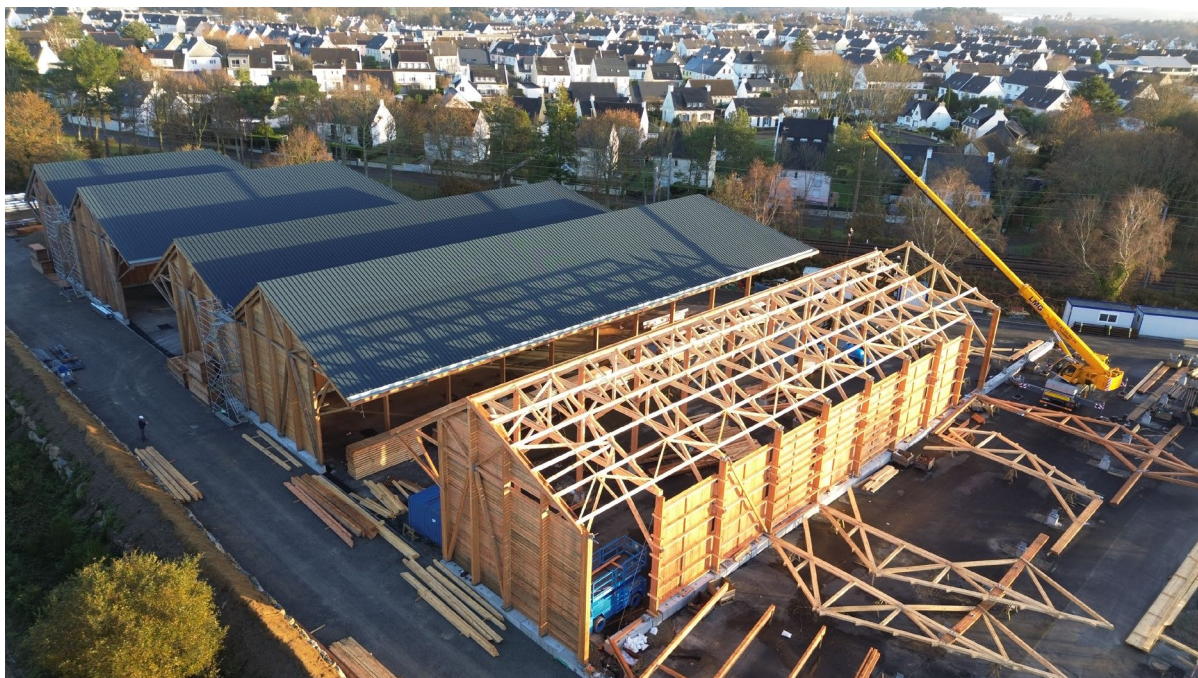
Montage de la charpente par EMG Structure Bois
