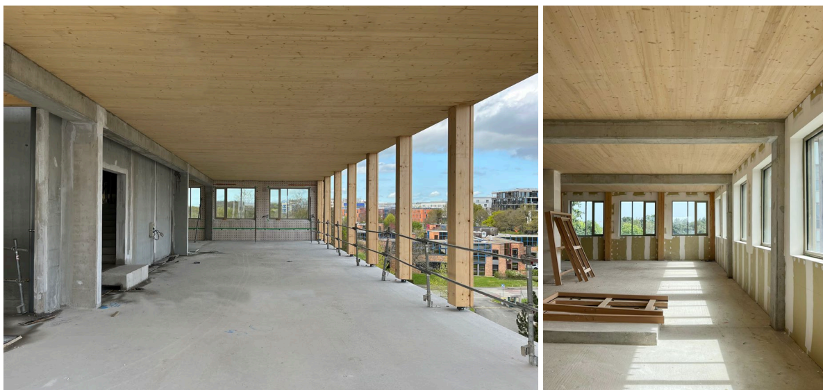
Image 5 : Canopia Santé, la structure HOB OA rendue apparente dans tout le bâtiment
