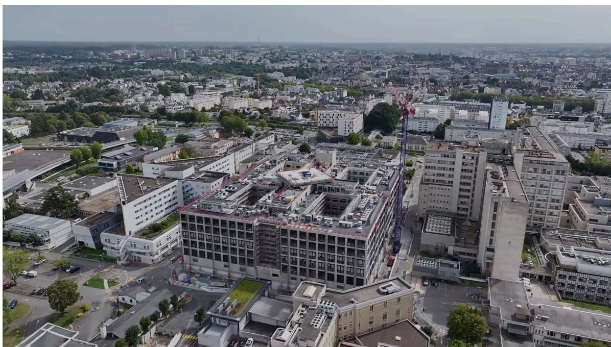
Photo du chantier du Centre Chirurgical et Interventionnel ©Christophe Le Potier
