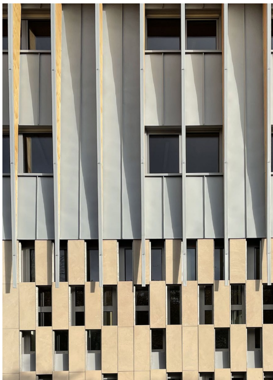
Parements en façade sud
