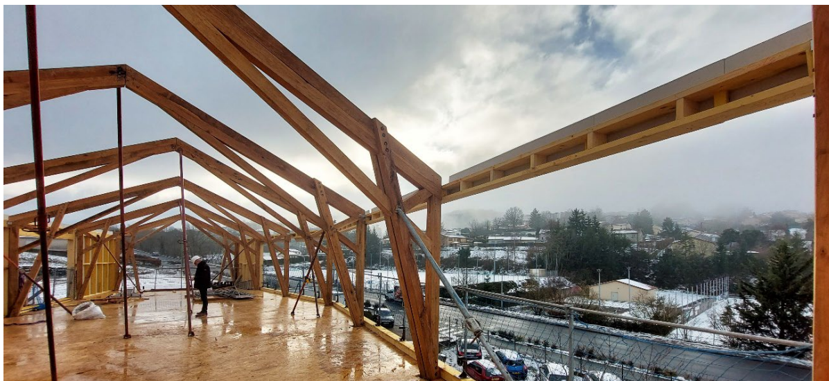
Image 6 : Photographie de chantier: des portiques en chêne
