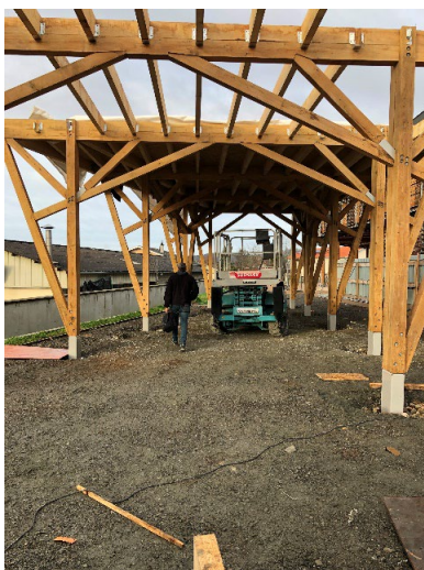
Réalisation du plancher
