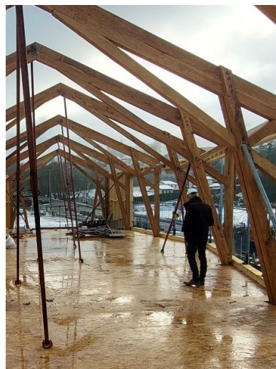
Mise en place des portiques étage
