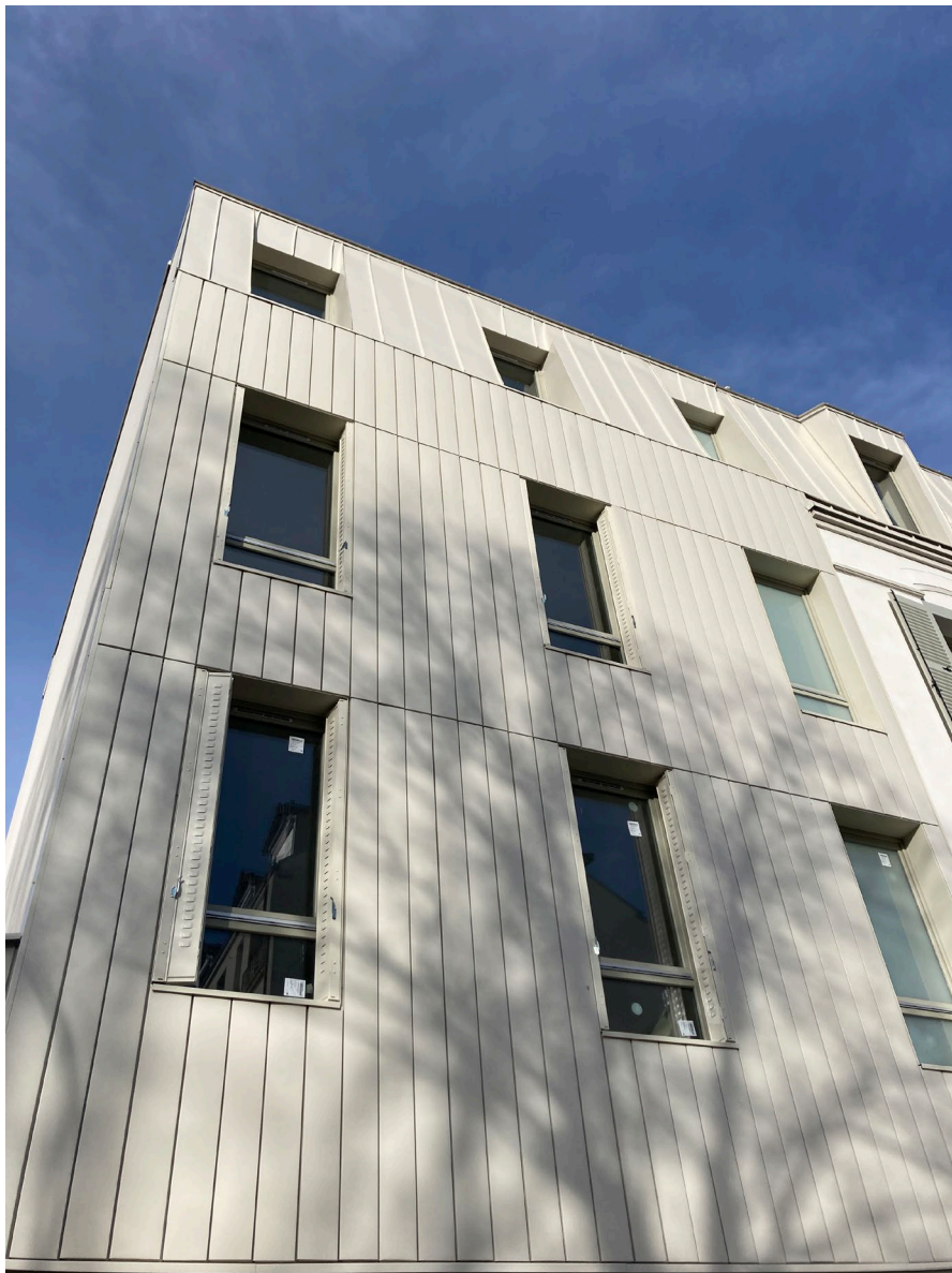
Façade extension en zinc bilaqué à joint creux
