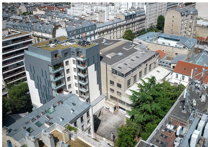
Vue arrière du bâtiment existant
