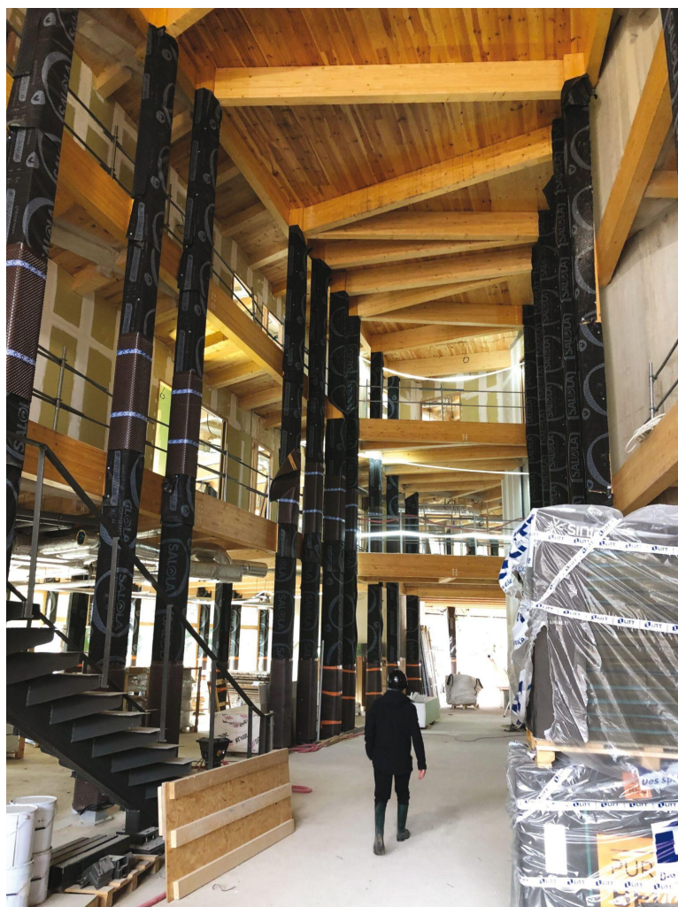
À Maisons-Alfort, le nouveau siège de l'ONF par WOA avec Mathis est une prouesse de l'architecture bois francilienne. Photo : Jonas Tophoven
