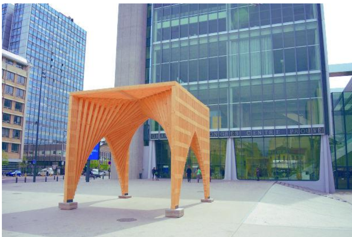
Le Centre Prouvé qui accueille le Forum Bois Construction 2022 à Nancy. crédit photo : Cmp Bois
