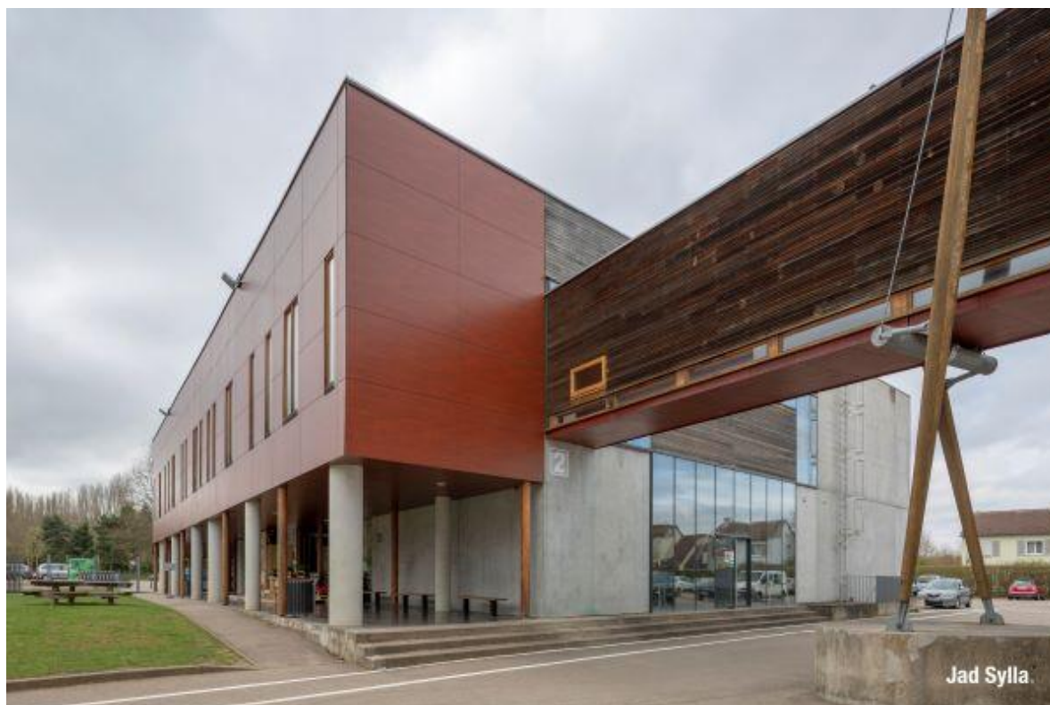
L'ENSTIB recourt de plus en plus au bois
