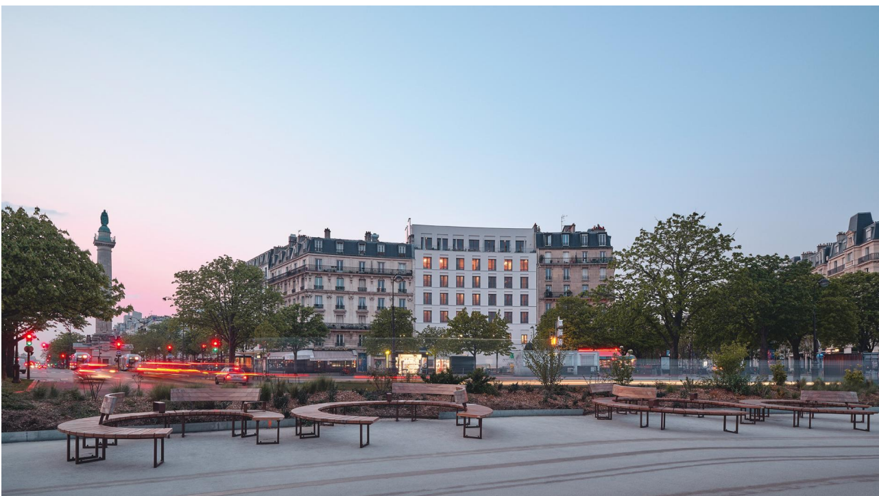
« Les Piaules », place de la Nation à Paris. Cette surélévation de 5 étages en CLT, conçue par l'agence JBMN Architectes, abrite une auberge de jeunesse de 1 100 m 2 . Une architecture moderne et bas carbone qui s'intègre parfaitement dans le quartier haussmannien. Photo : Jérôme Epailard
