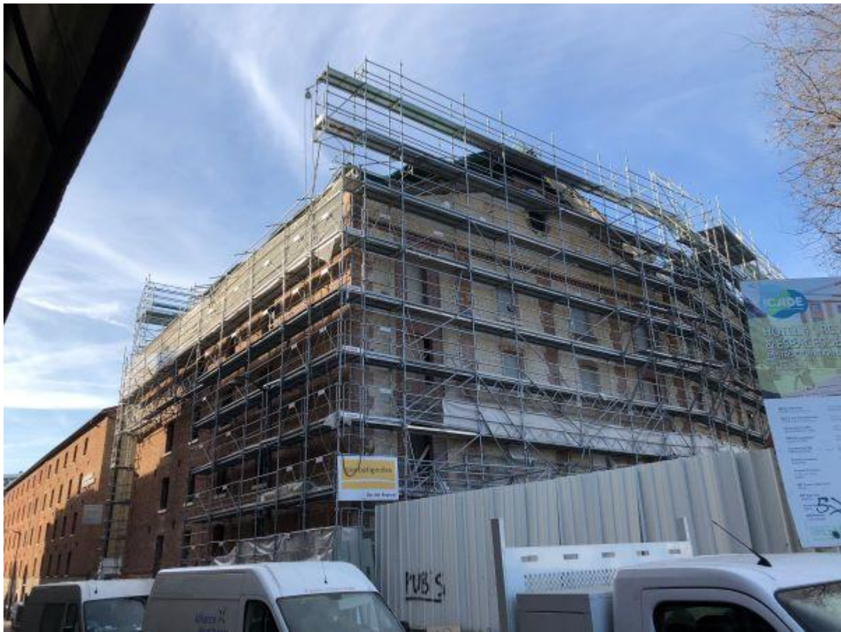
Aspect actuel de la façade fin février 2022
