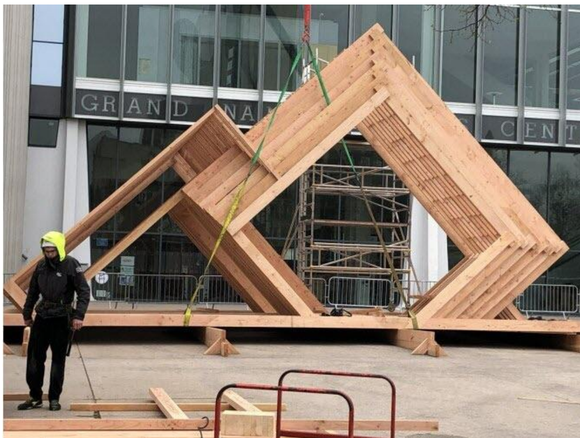
Les apprentis des Compagnons du Devoir montent la structure à plat avant de l'emboîter à la verticale. Photo ER /Ju.B.
