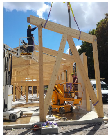
Usinages et découpe numériques | Préfabrication des MOB | Levage de la charpente © Béal-Blanckaert
