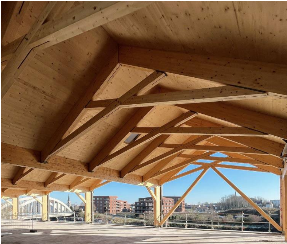
Charpente visible du futur restaurant d'entreprise (photo GBL Architectes)
