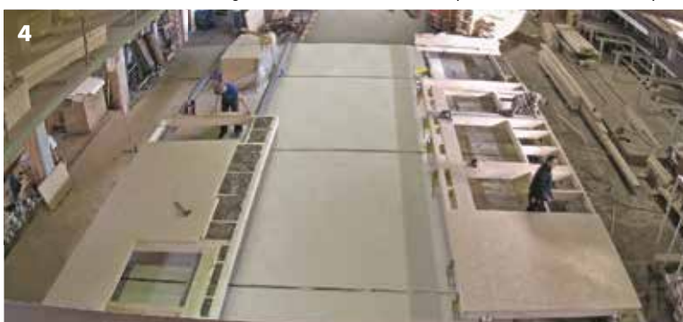
4 / Fabrication d'un élément mural à une hauteur de travail idéale : parfaitement ergonomique même pour la pose de piliers lourds, puisque la « table est praticable »
