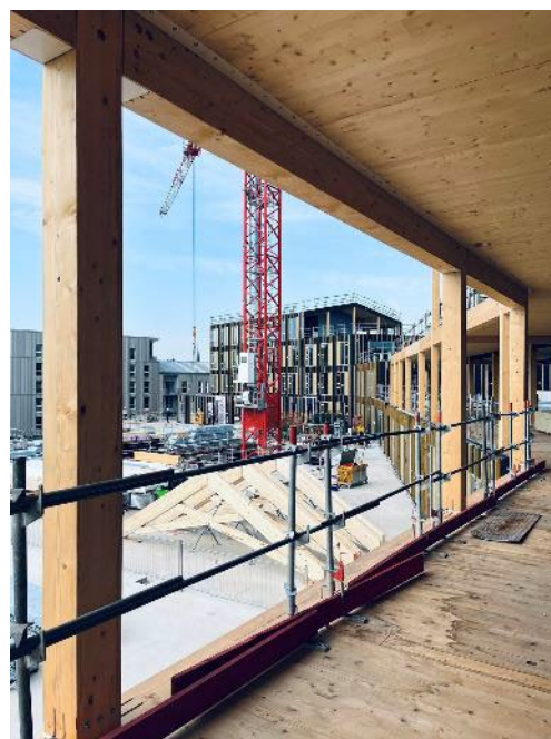
Système poteaux-poutres – façades non-porteuses (photo GBL Architectes)
