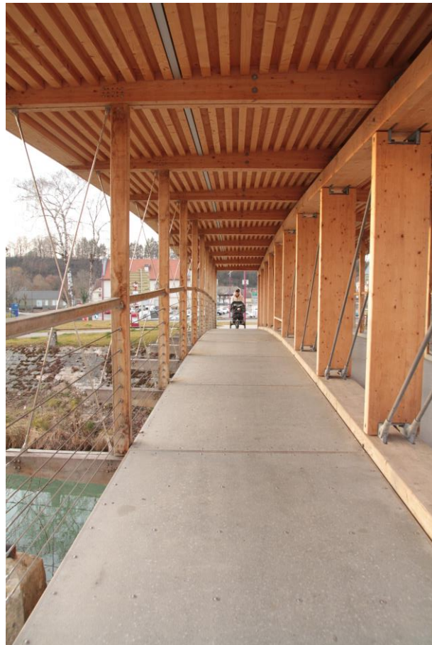
Photo 6 : Vue intérieur avec la poutre centrale
