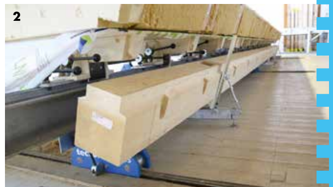
2 / Réalisation d'une charpente avec panne faitière
