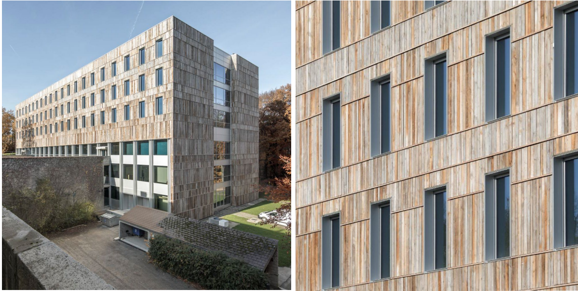
6A architects – Logement étudiants de Cowan Court / Bardage issu du réemploi et poncé sur le motif
