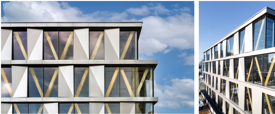
Façades rythmées par la maille structure en diagonale (©Marc Detiffe).
