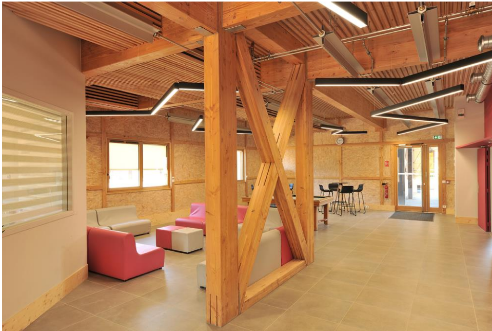
Lycée St-Joseph, St-Didier-sur-Chalaronne (01), crédit photo : studio Gaudin Ramet plafond : sous-face de plancher Lignadal 42 / murs : contreventement OSB blanchi MOB douglas 69, plinthe en bois cachant les réseaux électriques, structure bois apparente douglas 69, caisson Sylvacoustik 69. Radiateurs, gaines vmc, chemins de câbles : apparents.
