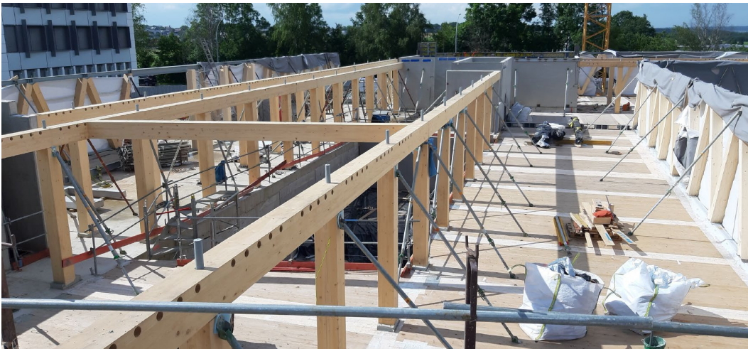
Trame structure intermédiaire avec percements et connecteurs.
