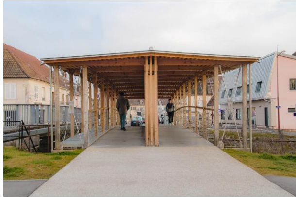
Photo 1 : Entrée de la passerelle
