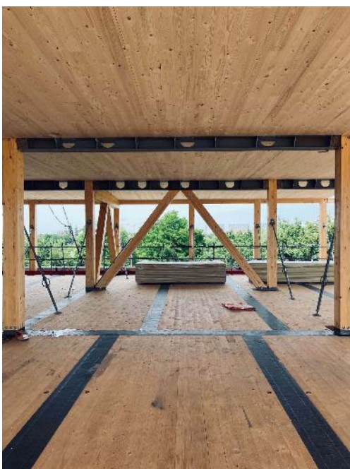
Système poteaux-poutres – façades non-porteuses (photo GBL Architectes)
