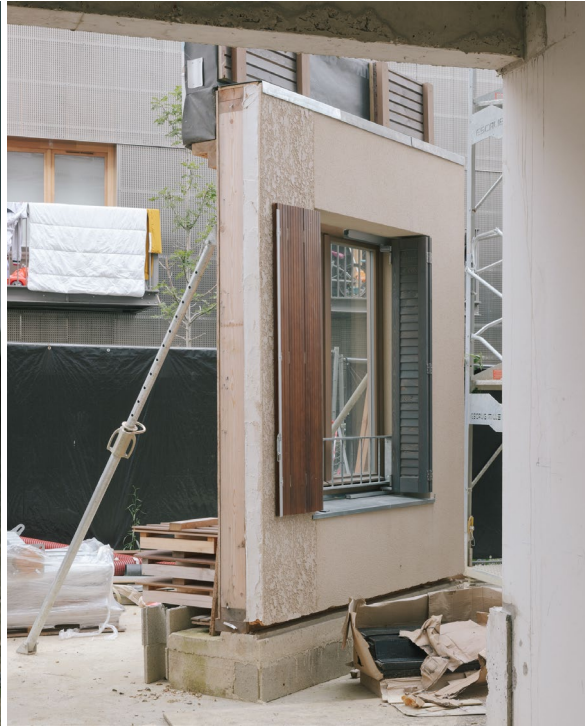
Images 4–5 : Prototype de façade, servant à la représentation des techniques et des matériaux de façades – printemps 2021 © Charly Broyez
