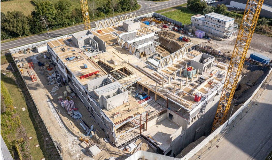
Vue aérienne du chantier, côté sud-ouest (©Marc Detiffe).
