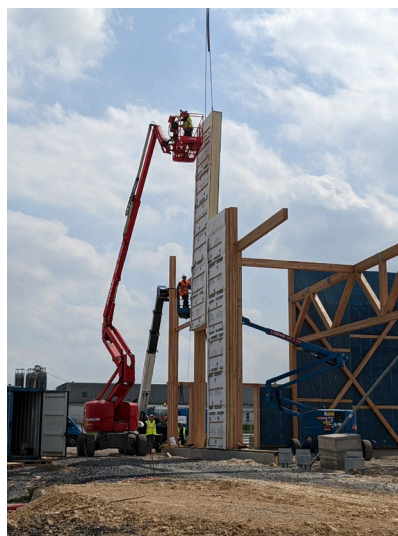
Image 4 : modification sur chantier (du à la dimension des caissons)
