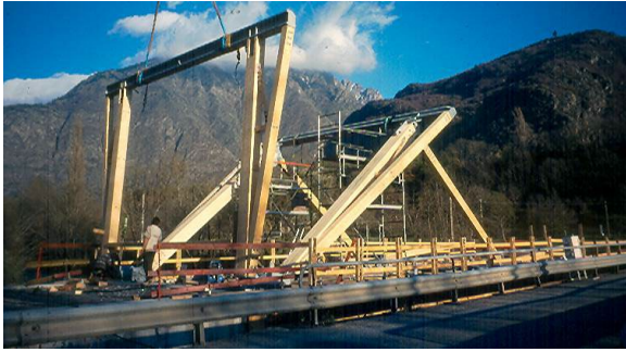
Montage du pont des Fayette pour pivotement des portiques latéraux
