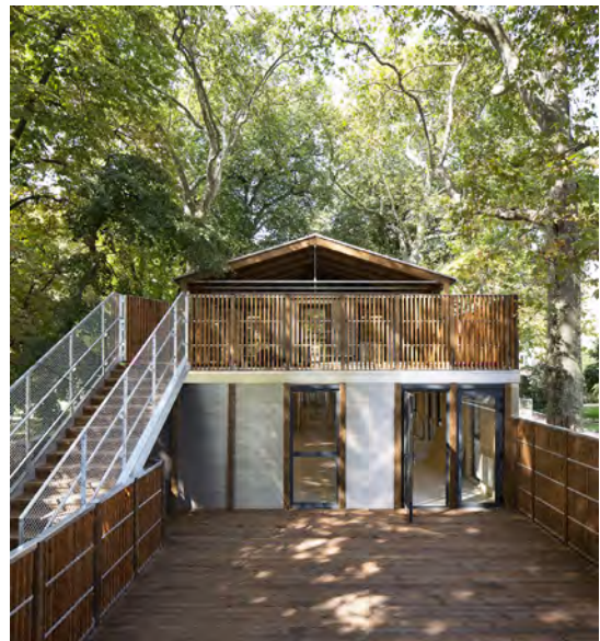
Crèche du Luxembourg élément démontable ©Clément Guillaume
